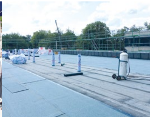
AFG 3-fach-Sporthalle Grundsteinlegung und Richtfest
