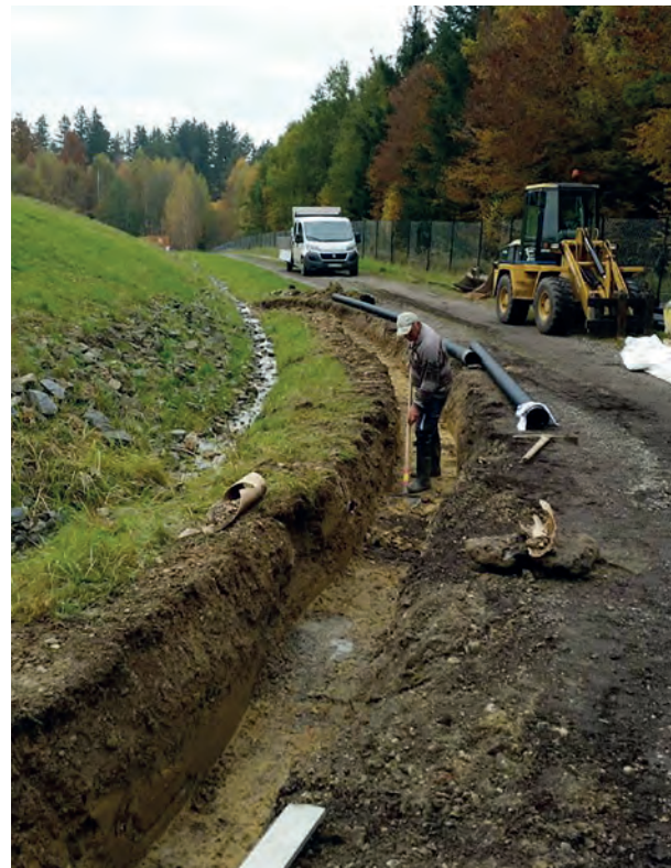
Bau einer Drainage
