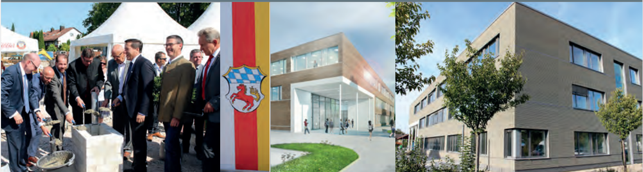
2017 Grundsteinlegung Neubau Bildungszentrum für Gesundheitsberufe Erding – Eröffnung 2018
